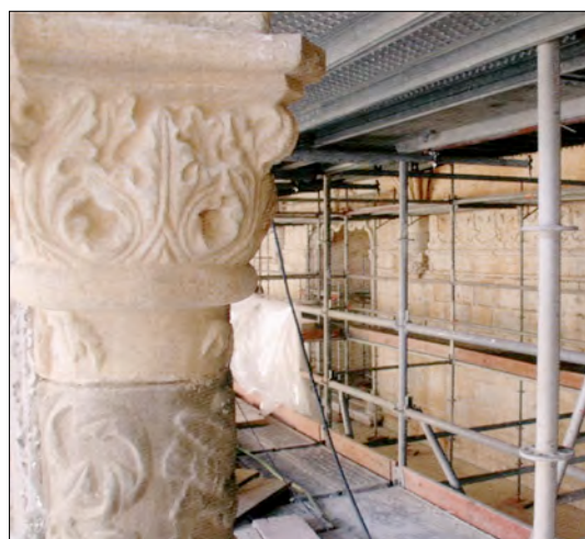
Fig. 3.17: Parte superiore dopo la pulitura laser, parte inferiore prima della pulitura.
