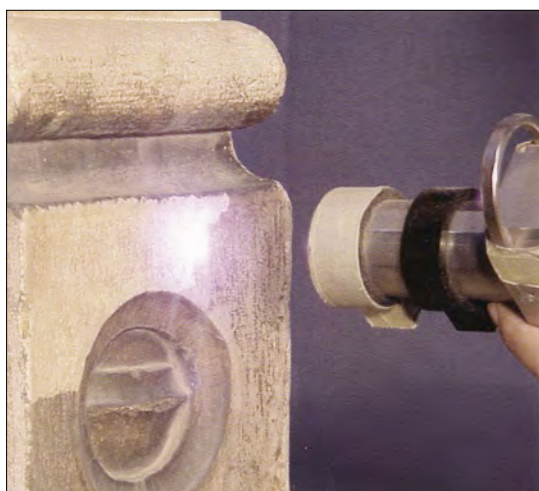
Fig. 3.16: Vista del raggio laser incidente sulla pietra per la relativa pulitura.
