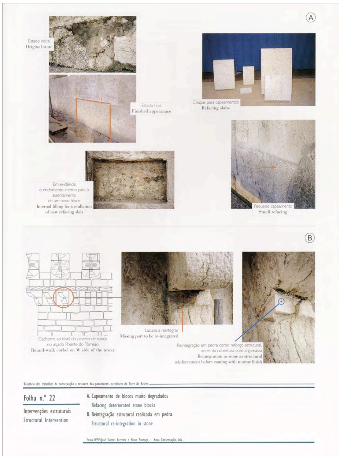
Fig. 3.4: Scheda tecnica inerente gli interventi strutturali realizzati presso la Torre di Belém.
