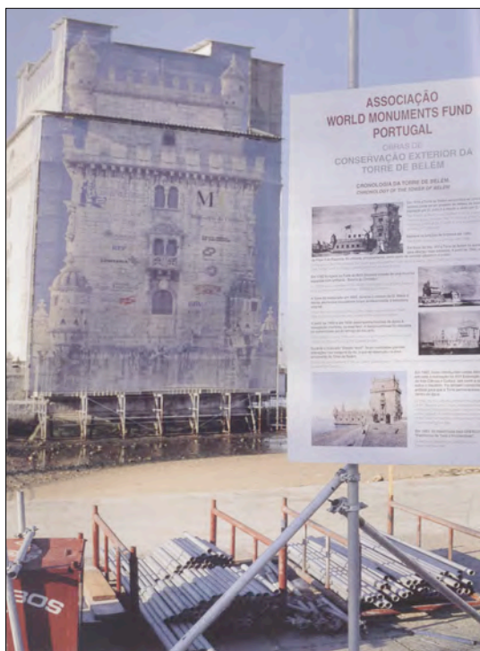
Fig. 3.2: Ponteggi realizzati durante il restauro della Torre di Belém.
