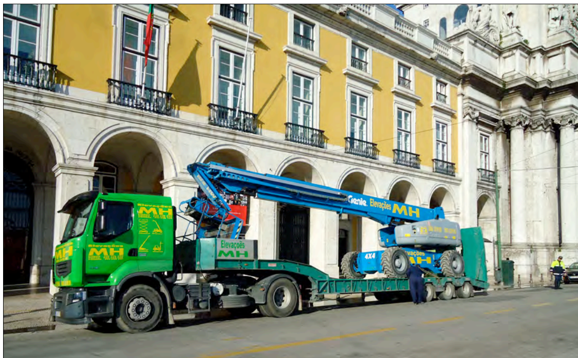
Fig. 4.23: Piattaforma elevatrice impiegata in fase di rilievo laser scanner.
